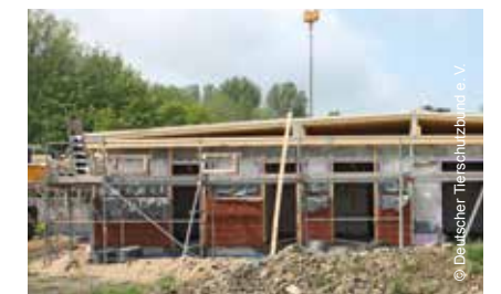
Spenden in Höhe von rund 100.000 Euro ermöglichen die Baumaßnahmen.
